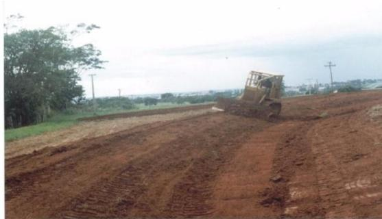
**Figura 4.** Construção de terraços com máquina de esteiras.
